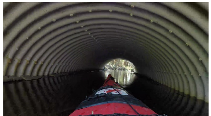
Unter der Strassenbrücke
